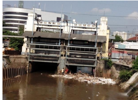
Gambar 1. Pintu Air Manggarai
