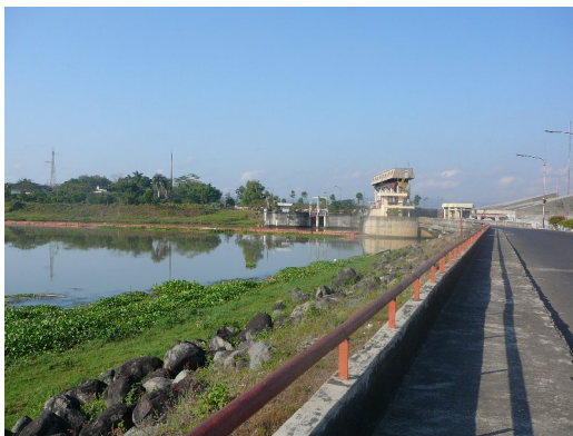
Gambar 1. Bendungan Wlingi di Desa Jegu, Kec. Sutojayan, Kab. Blitar
