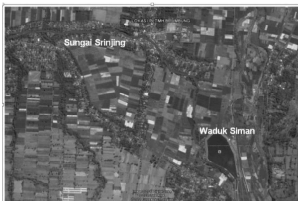
Gambar 2. Lokasi PLTMH Brumbung
